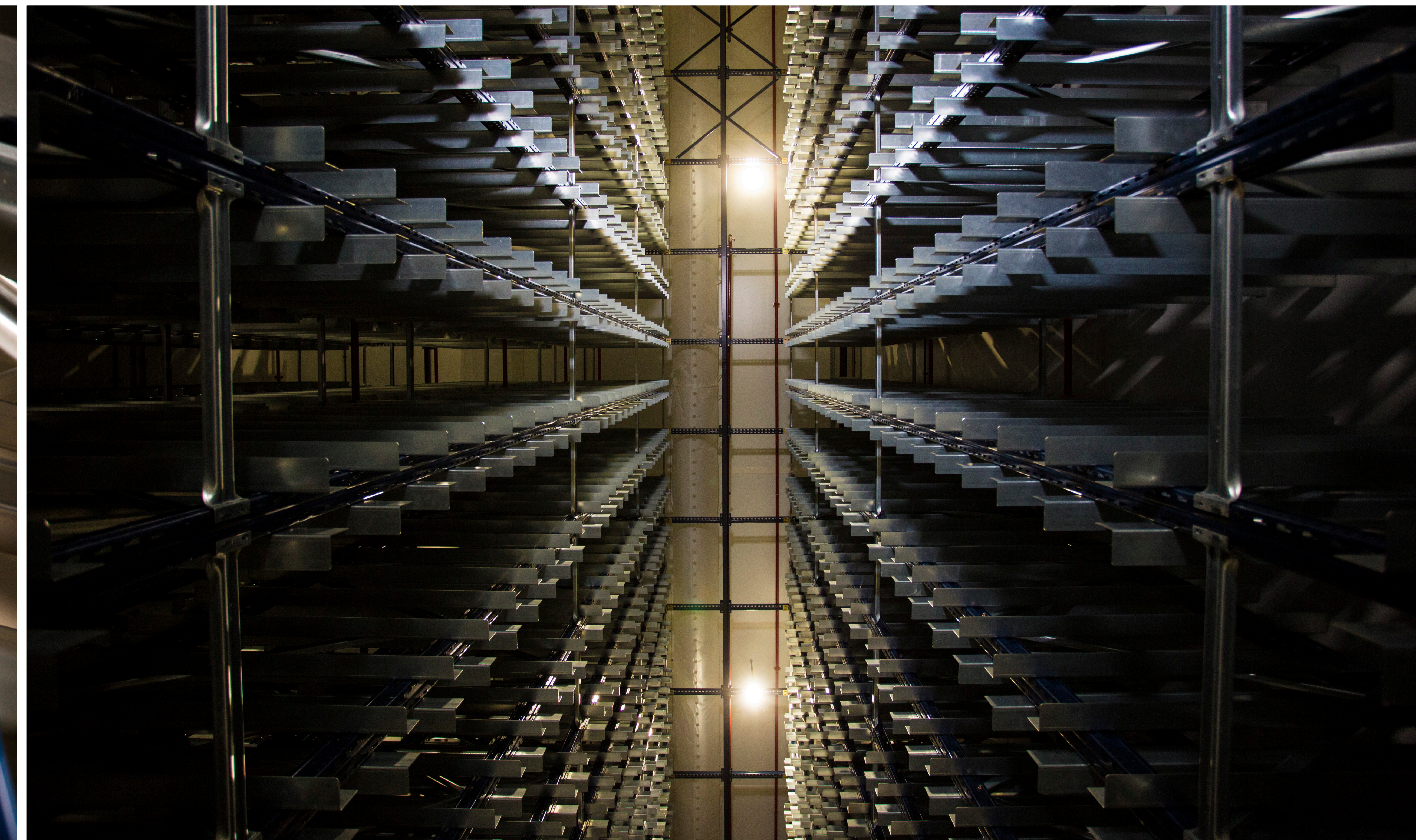
Aisle of the warehouse/Allée du magasin
